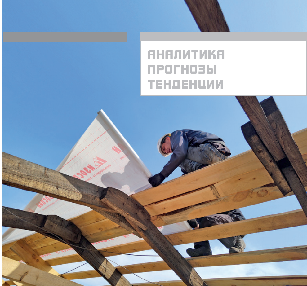
Работы по строительству, благоустройству территории идут полным ходом
