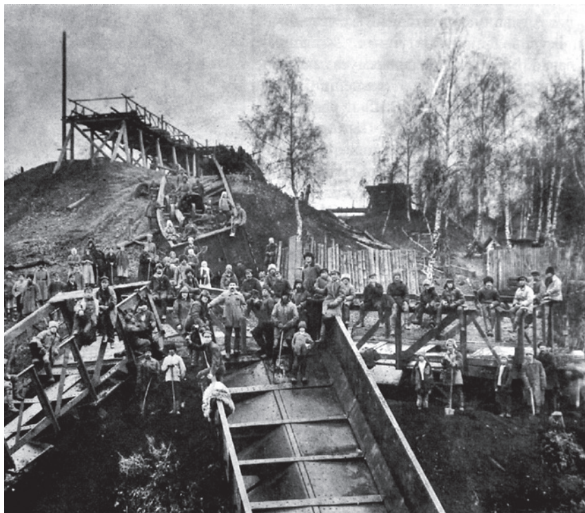
1922 год. Строительство шахты «Жури́нская»
